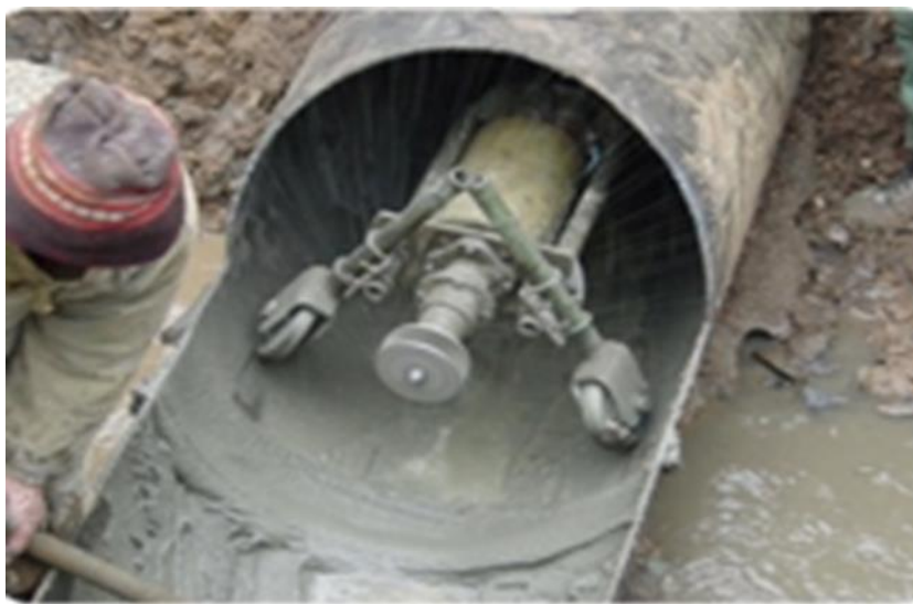
Рис.1. Метод нанесения цементно-песчаного покрытия.
