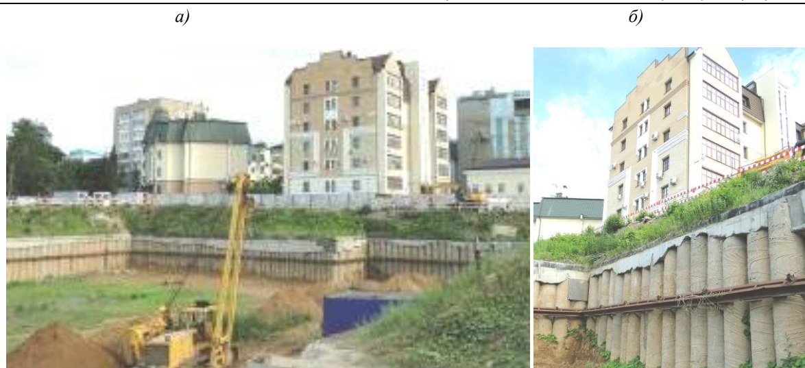
Рис. 1. Общий вид пионерного котлована, по состоянию на 2017 г., вскрытого в 2006 г. на глубину 6-8 м и удерживающих стен из БНС для вновь возводимого здания «Бизнес центра»
