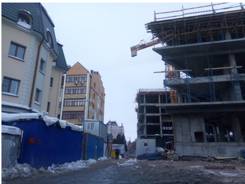
Рис. 6. Завершающий этап инструментального геодезического мониторинга и возведения несущих конструкций каркасного остова вновь возводимого многоэтажного здания «Бизнес центра» (на фото справа), расположенного вблизи от существующих многоэтажных зданий №13, №78, №28а
