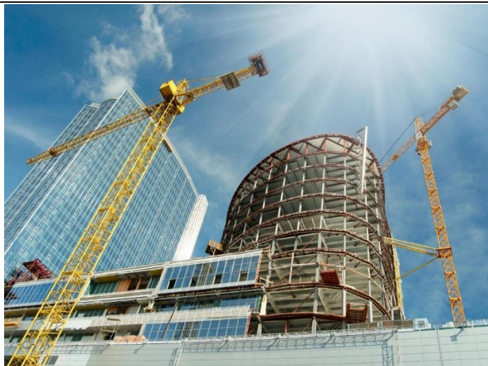
Рис.2 Строительство жилого комплекса
