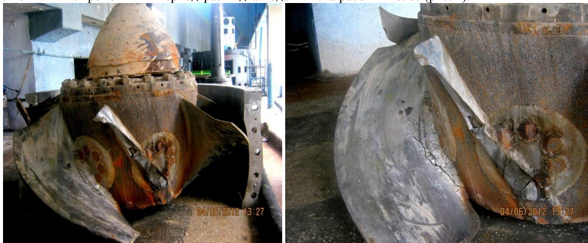
Рис. 1. Кавитационный износ в рабочих колесах Бозсуйской ГЭС
