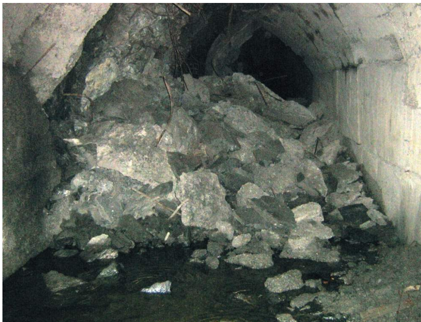
Рисунок 1 – Нарушения в горных выработках, опасных по горным ударам
