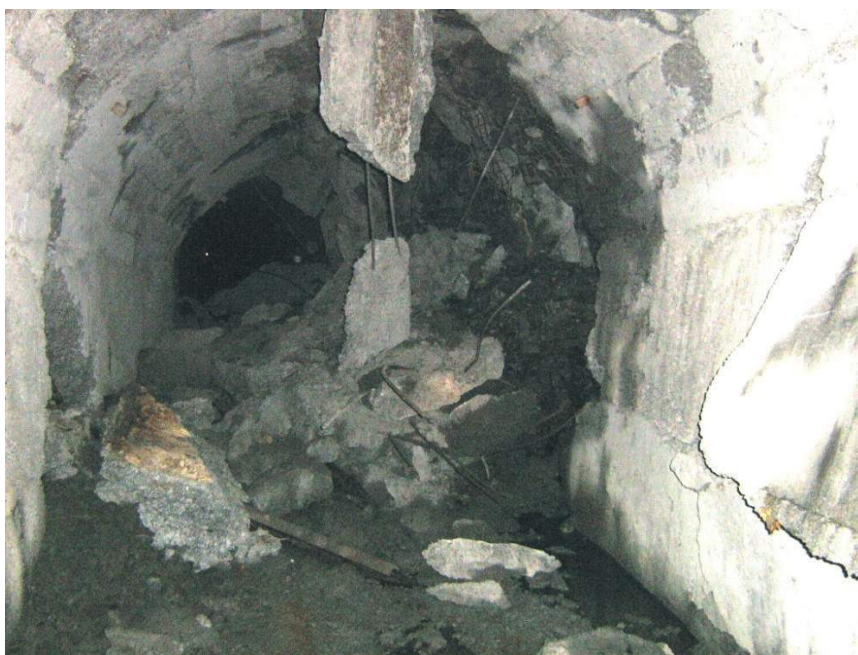
Рисунок 2 – Нарушения в горных выработках в результате происшедших микроударов
