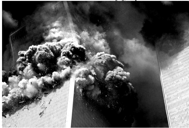
Рис. 12. Террористическое разрушение башен в Нью-Йорке
